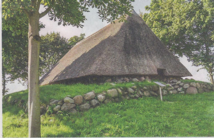
Auf einer natürlichen Anhöhe liegt das reetgedeckte Gebäude des Eiskellers.
